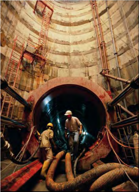
Tanah Merah Link Sewer
